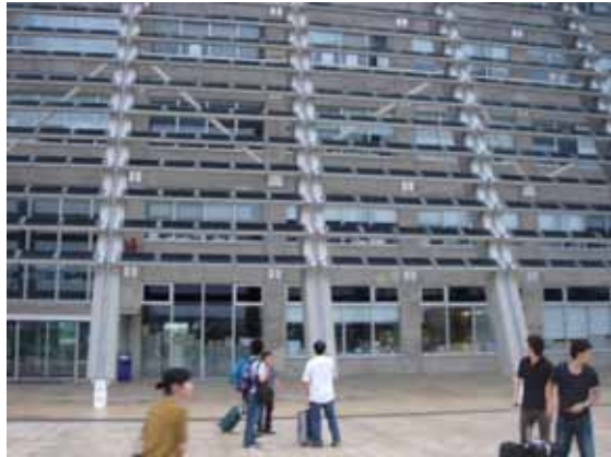
Photo 1 糸満市新庁舎
