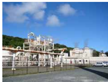
八丈島地熱発電所
